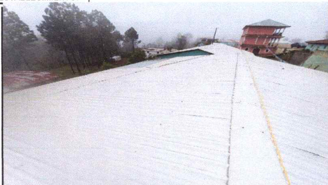
Foto 1: CAMBIO DE LAMINA EN EDIFICIO ESCOLAR 1 Y 2 CON LAMINA TROQUELADA DE ALUZINC CALIBRE 26 MAXALUM, Y SUSTITUCION DE CAPOTE
