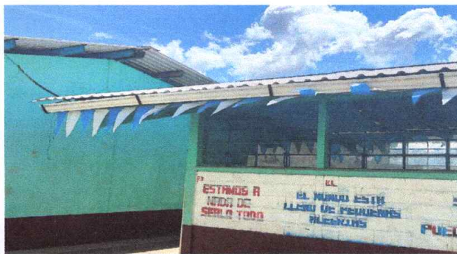
Foto 4: SUSTITUCION DE CANAL DE PVC EN EDIFICIO 1, INCLUYE LA SUSTITUCION DE BAJADAS DE AGUA PLUVIAL CON TUBERIA DE PVC DE 3" MARCA "MULTITUBO"
