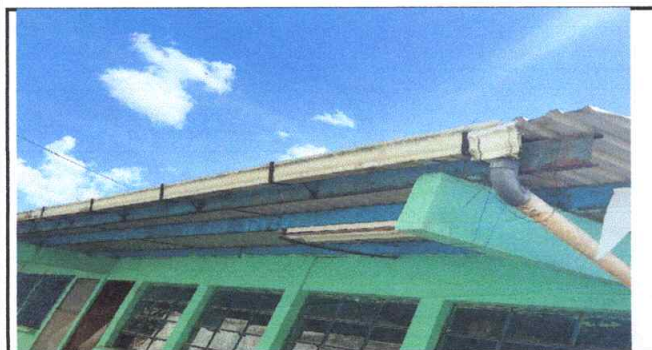
Foto 5: SUSTITUCION DE CANAL DE PVC EN EDIFICIO 2, INCLUYE LA SUSTITUCION DE BAJADAS DE AGUA PLUVIAL CON TUBERIA DE PVC DE 3" MARCA "MULTITUBO"
