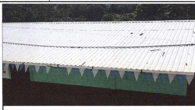
Foto 2: CAMBIO DE LAMINA EN EDIFICIO ESCOLAR 1 Y 2 CON LAMINA TROQUELADA DE ALUZINC CALIBRE 26 MAXALUM, Y SUSTITUCION DE CAPOTE
